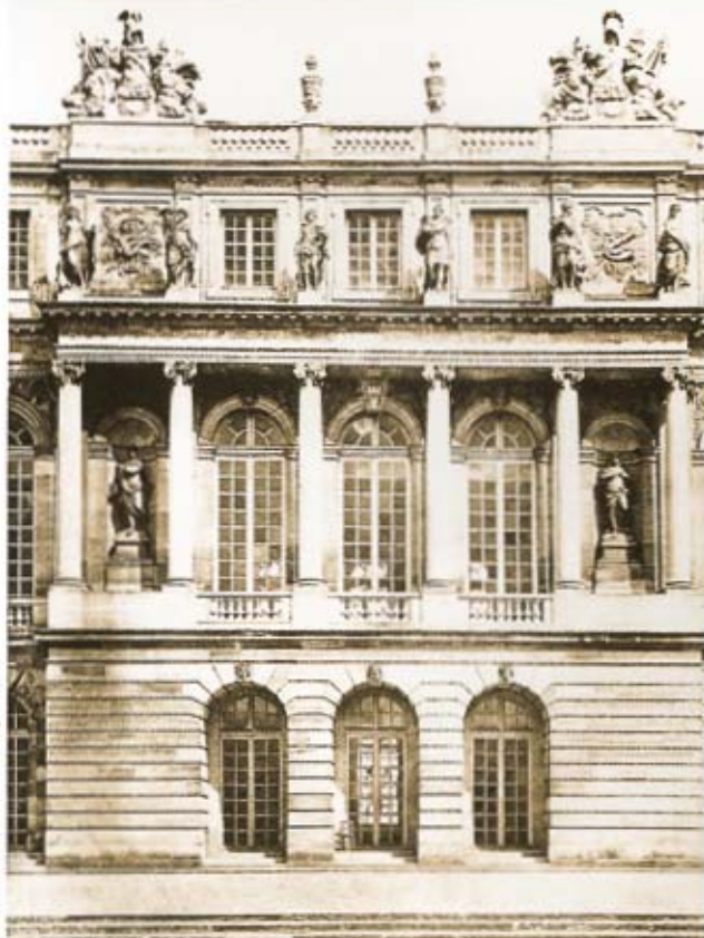
Fachada oeste, salida a los jardines
